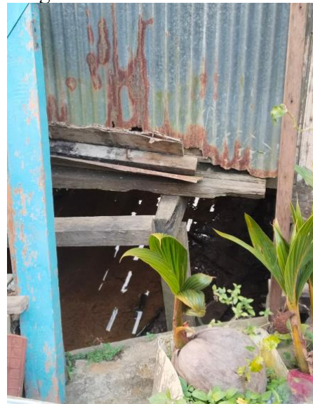
SPAL yang tidak memenuhi syarat karena air limbahnya langsung dibuang ke kolong rumah
