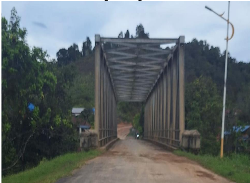
Gambar 8. Jembatan Desa Long Nawang
