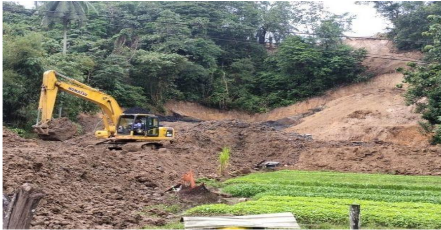
Gambar 10. Lahan warga yang terdampak kerusakan lingkungan akibat kegiatan penambangan di Kel. Handil Bakti, Kec. Palaran
