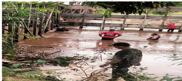
Gambar 2. Perbaikan jembatan penghubung desa
