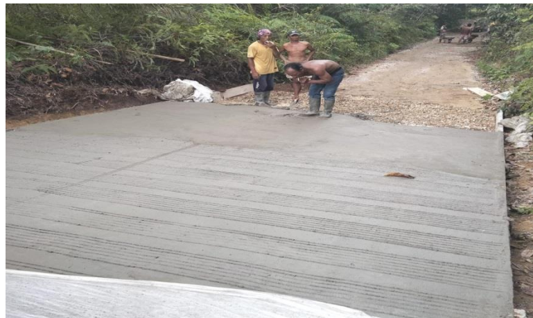
Gambar 1. Dokumentasi Pembangunan jalan lingkungan RT 01-RT 03
