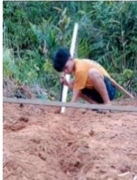
Gambar 10. Pemasangan Tiang Naungan
