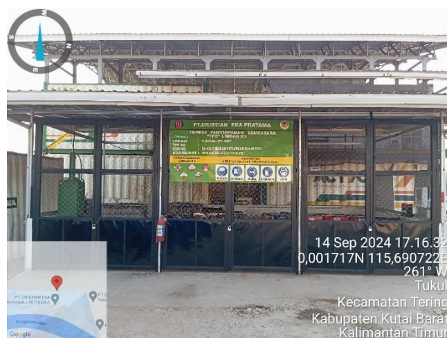
Gambar 1. TPS limbah B3 mempunyai atap Yang membuat terlindung dari sinar matahari dan hujan
