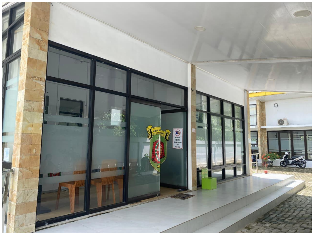
Gambar 8. Ruangan Kantor Kelurahan (Tampak Depan)
