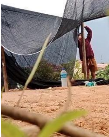
Gambar 9. Pemasangan tiang naungan
