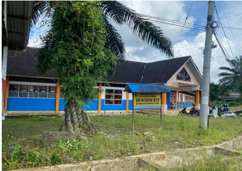
Gambar Gedung SDN 025 Samarinda Utara
